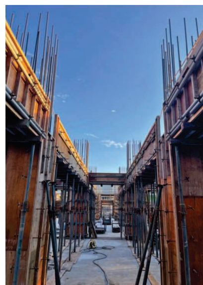
⇨ 型枠が組み上がって きている状況
