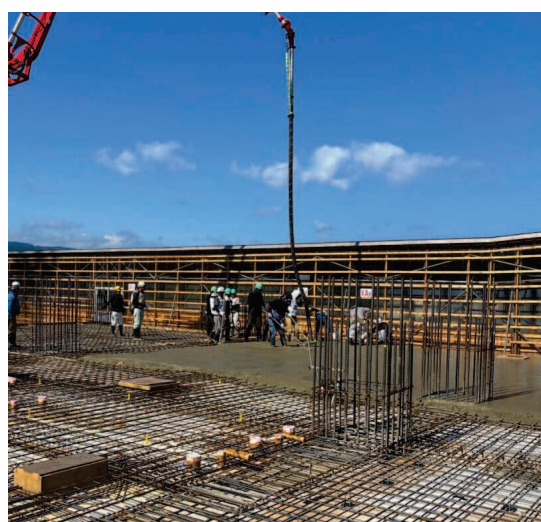
⇨ 1階床のコンクリート打設の様子
