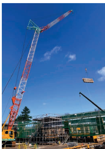
⇨ クレーンで型枠を吊り 梁をかけます
