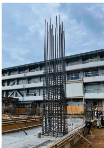
⇨ 柱の縦筋は、圧接して どんどん上に繋げます
