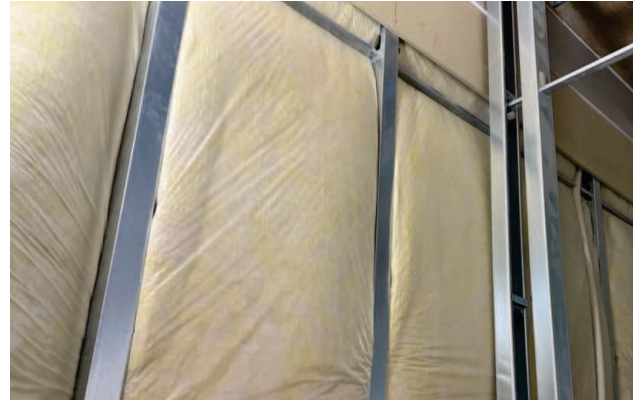
☆ トイレ回りはさらに グラスウールを入れて防音
